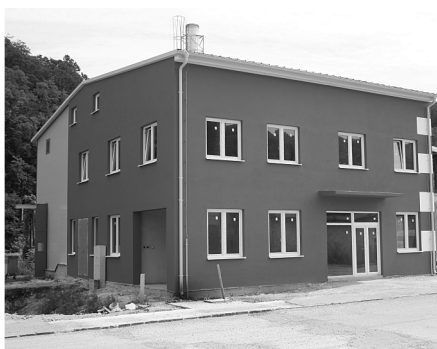
* Výstavba kotolne na štiepku
