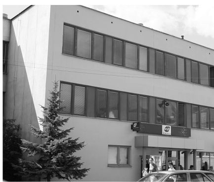
* Výmena plastových okien NsP
