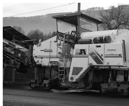
* Oprava vozovky ul. Hlavnej
