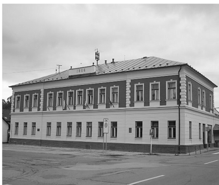
* Rekonštrukcia fasády MsÚ
