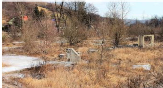
Na mieste zbúranej železolejárne neskôr vznikla pila. Aj jej objekty však boli pred zhruba 15 rokmi demontované a zostali len betónové torzá
