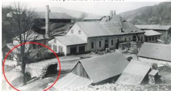
Železolejárň v Maši. V ľavom dolnom rohu je v krúžku vyústenie umelého kanála, ktorého voda poháňala vodné koleso
